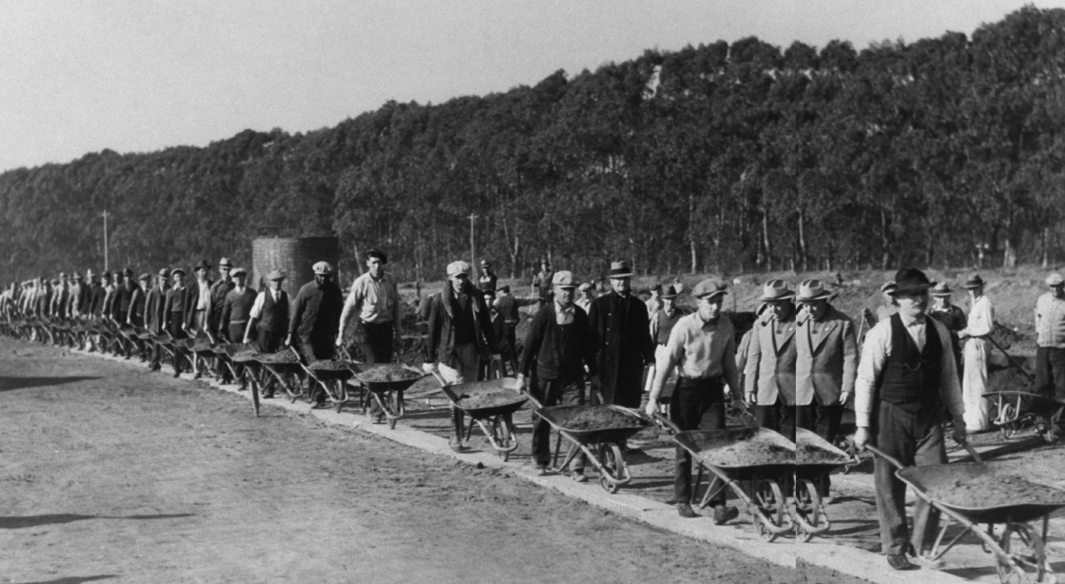
Arbeiders werken aan de aanleg van een boulevard in het kader van de New Deal van president Franklin D. Roosevelt. San Francisco, 1934.
